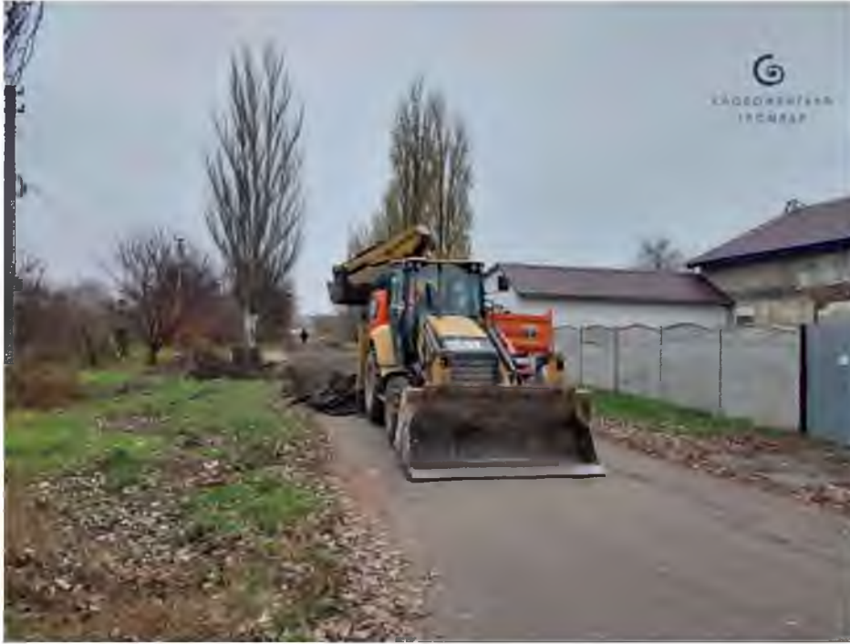
Під час ремонту по вул. Доновського.
